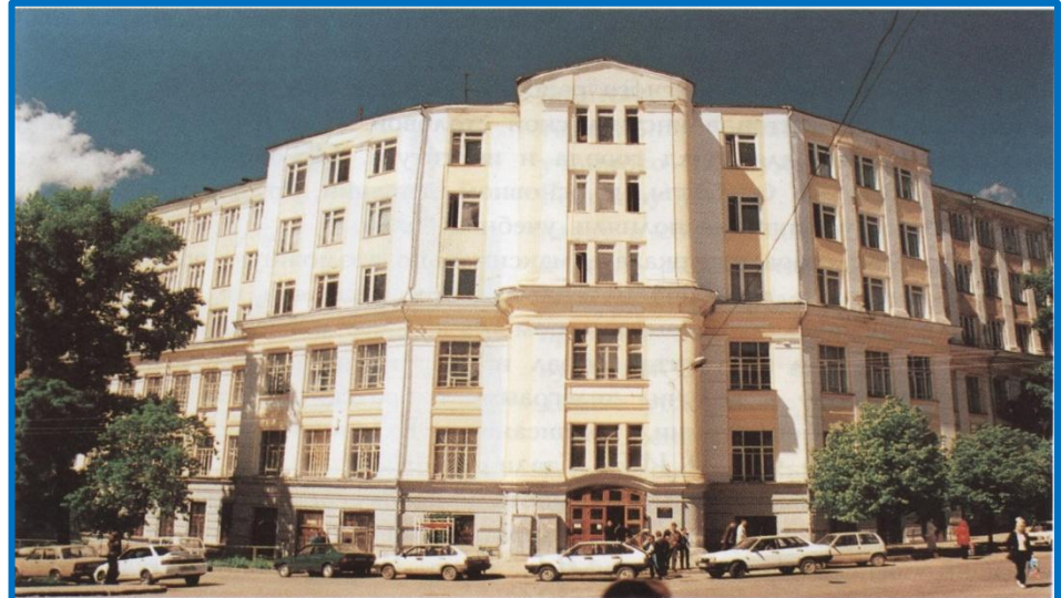
Угол улиц Молодогвардейской и Ульяновской. На двух верхних этажах этого здания институт размещался в 1945-1970 гг. Ныне учебный корпус Самарской архитектурно-строительной академии
